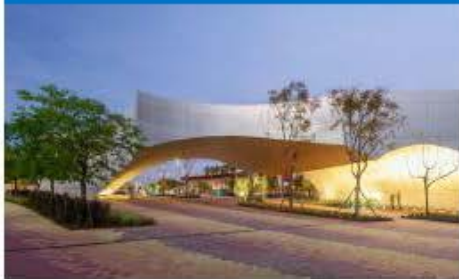
Caixaforum de Sevilla
